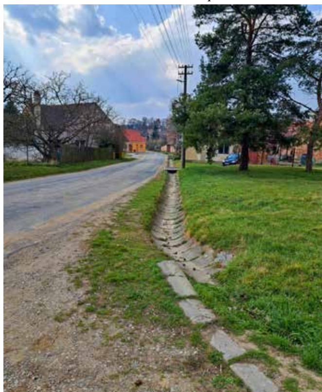
❑ Foto: Odvodnění komunikace - 2. etapa
