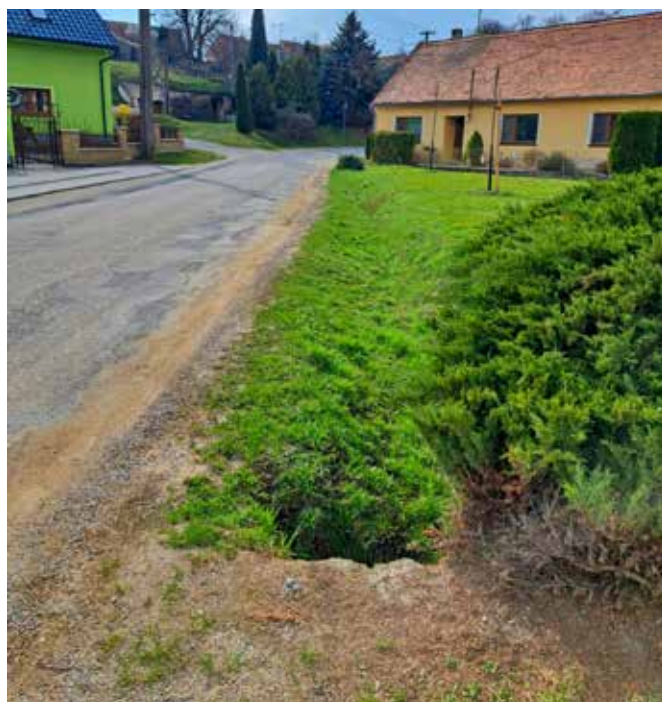
❑ Foto: Odvodnění komunikace - 1. etapa
