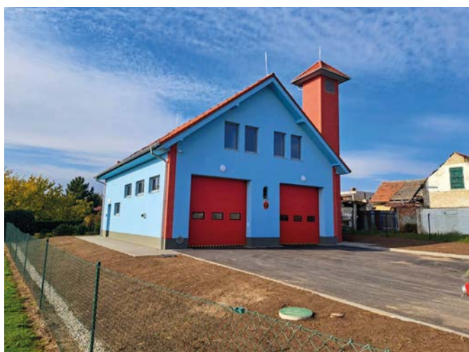
□ Foto: Stavba hasičské zbrojnice – 10.2024
