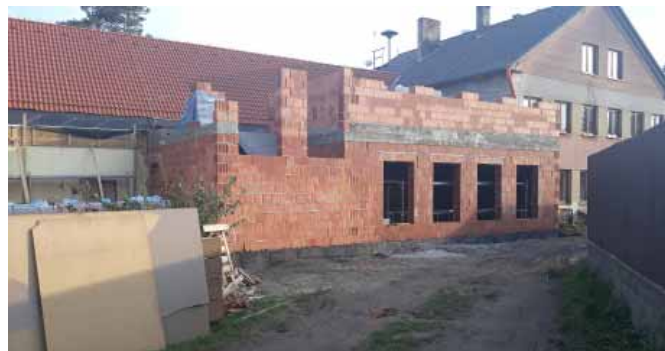
□ Budova ZŠ - přístavba
